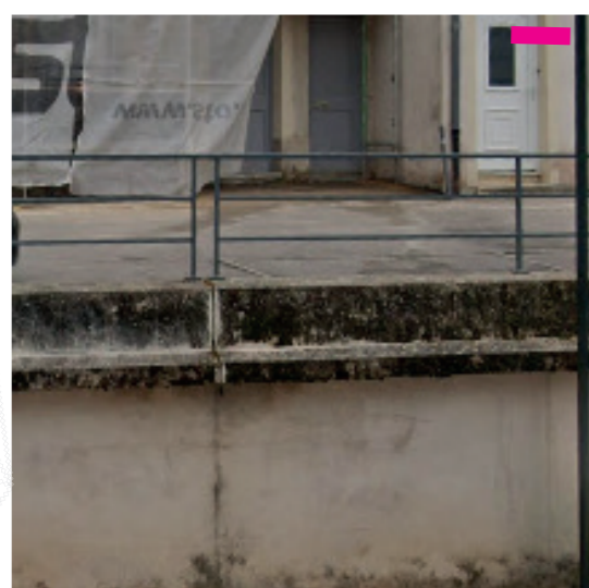
Barrières en métal sur mur de soutènement
