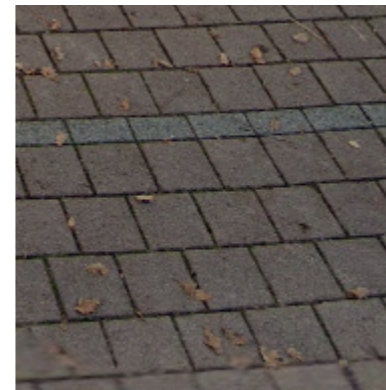
Trottoir: pavés béton rouge
